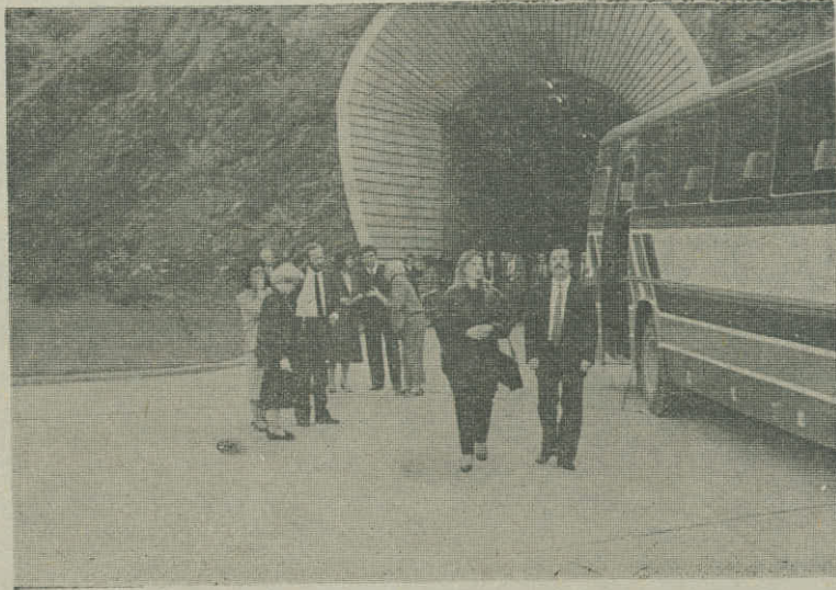
— Termik Santralın Yer Altı Giriş Tüneli. —
