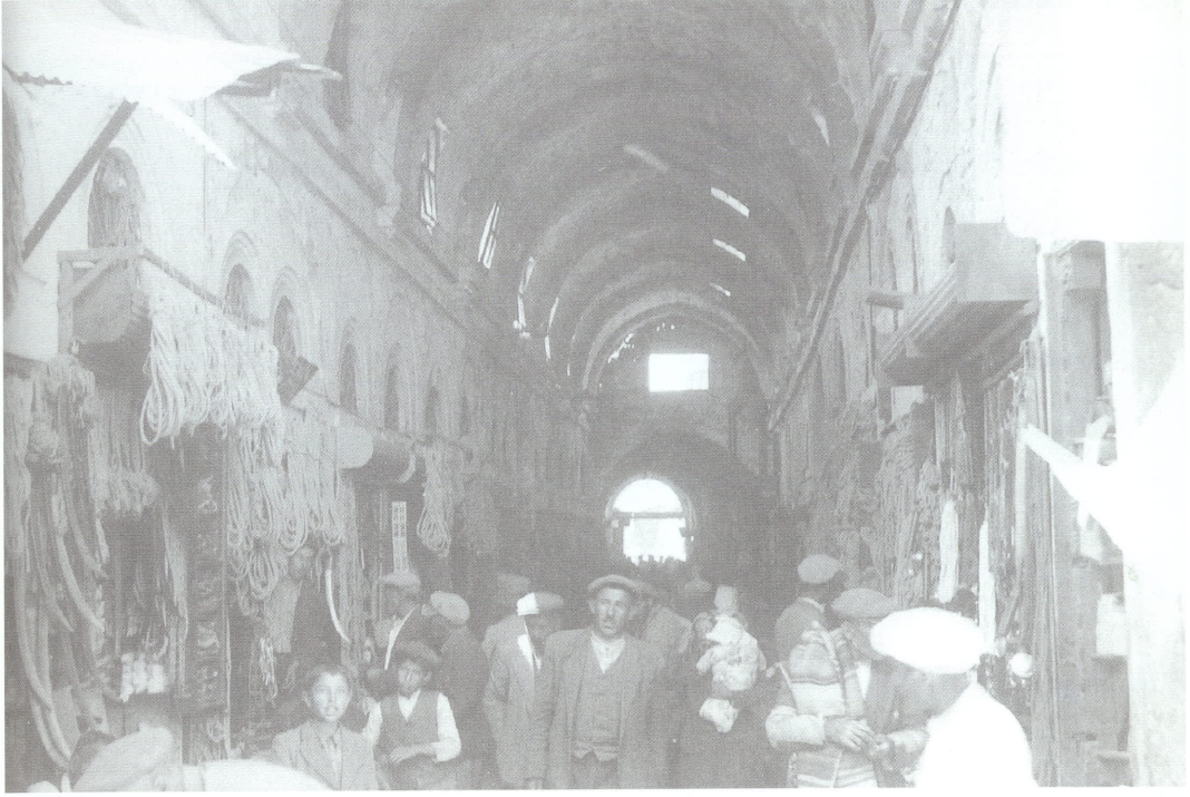
İçinde Attarlar Çarşısı'nın da bulunduğu Kapalı Çarşı'nın 1950'de çekilmiş bir fotoğrafı (Anımsamalar 2002, Erciyes Üniversitesi Yayınları)
